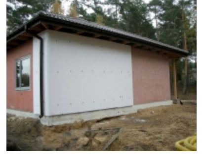
Dış Cephe Yalıtım
