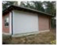
Dış Cephe Yalıtım
